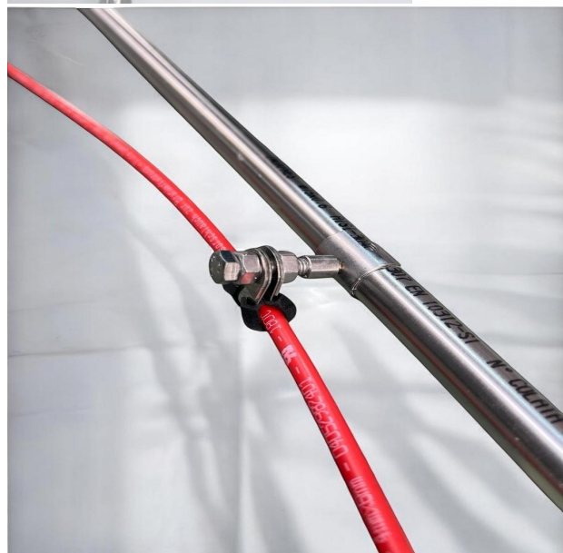
Detalle tubo térmico y tubo acero inox.
